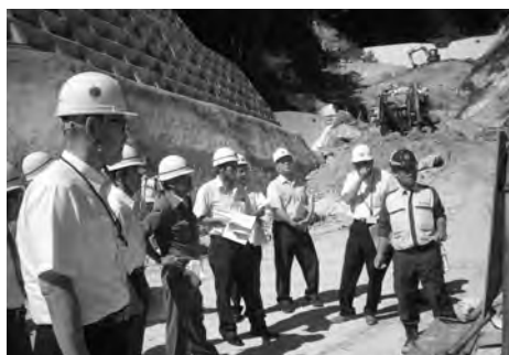
認定こども園施工状況視察
