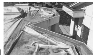
【敷根公園トイレ屋根の現状】
