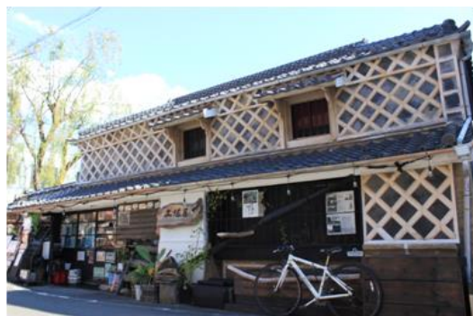
土佐屋（安政元年(1854)建築）
