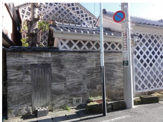
伊豆石の塀となまこ壁の建物
