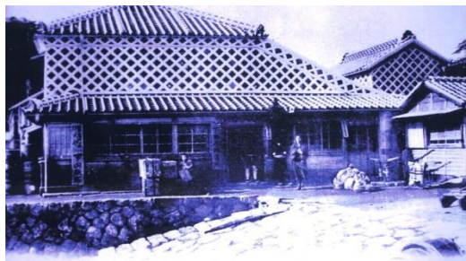
河岸端のガンゲ（斜路）
