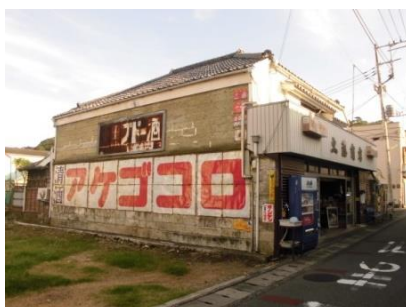
土藤商店 (明治20年(1887)建築)
