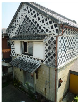
櫛田蔵 (明治40年(1907)頃建築)
